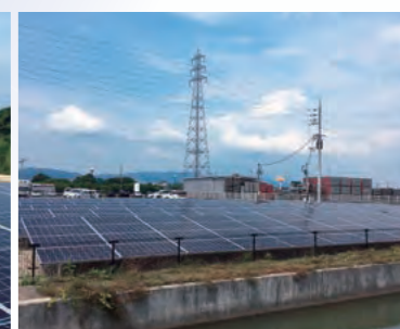
和歌山ソーラー発電所 Wakayama Solar Power Plant
