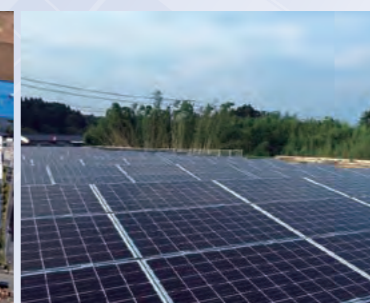
鹿児島ソーラー発電所 Kagoshima Solar Power Plant
